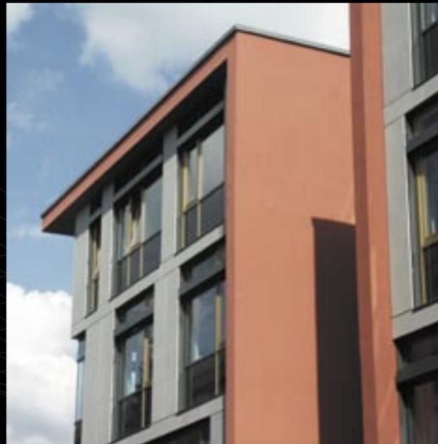
*Für das Berufskolleg in Mettmann wurden Fassadenelemente mit Abmessungen bis zu 1.100 x 3.100 mm in einer Stärke von 25 mm in der Standardfarbe "nebula" betongrau ausgeführt. Die Oberfläche "polish" wurde durch Schleifen der Rohoberfläche erhalten. Mittels Hinterschnittankern sind die Elemente an einer Aluminium Unterkonstruktion befestigt. Die Hinterlüftung beträgt 50 mm, die Fugenbreite rd. 15 mm.*
