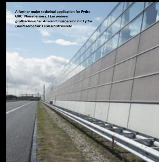
A further major technical application for Fydra GRC: Noisebarriers. | Ein anderer großtechnischer Anwendungsbereich für Fydra Glasfaserbeton: Lärmschutzwände.
